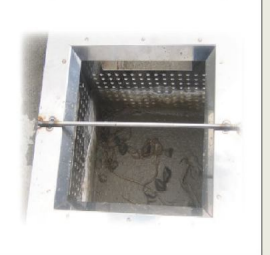
泥水投入後状況
