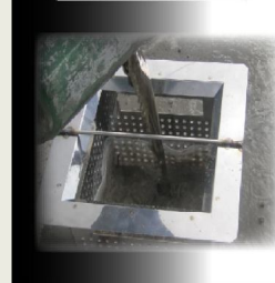
泥水投入状況
